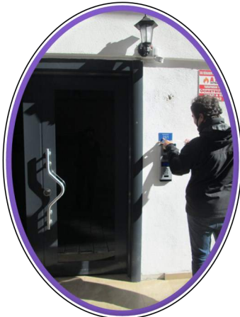
Bina Dış Kapı Numarası Asılması
