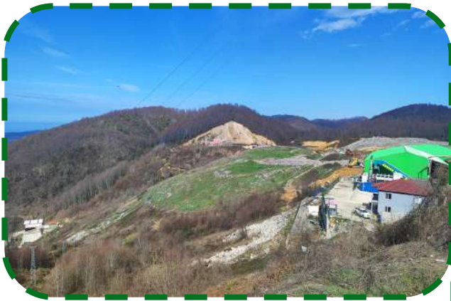
Sapça Düzenli Depolama Tesisi
