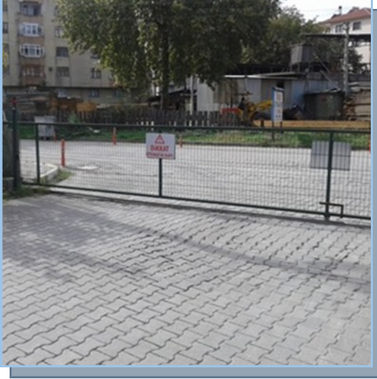
Kapı imalatı ve montajı
