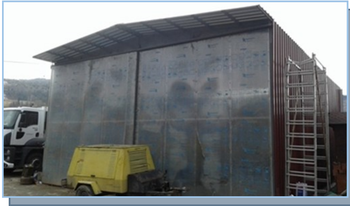
2 Araçlık kapalı garaj imalatı ve montajı
