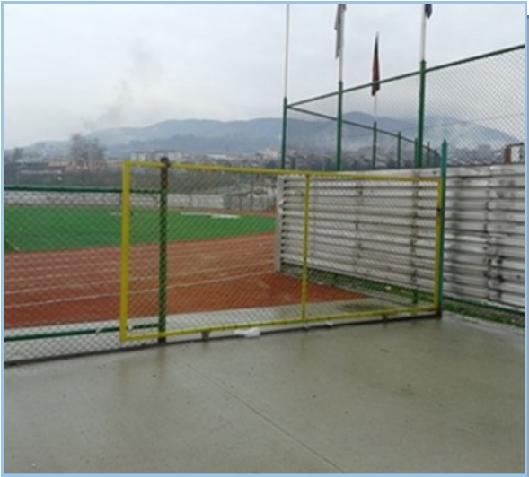
Devrek şehir stadyumuna kapı imalatları ve montajı,tribün kaynak işleri yapımı,turnike tamirati
